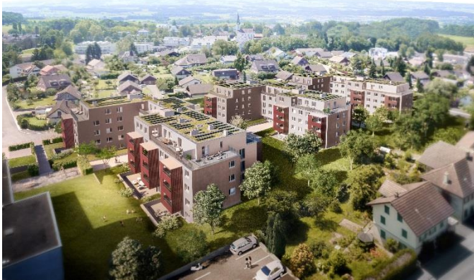
Abbildung 11: Siedlung Sentmatt, Obfelden: Der Strom aus den Hybridkollektoren wird für den Betrieb der Wärmepumpe und für den Allgemeinstrom im Eigenverbrauch genutzt. Bildquelle: Halter Immobilien AG
